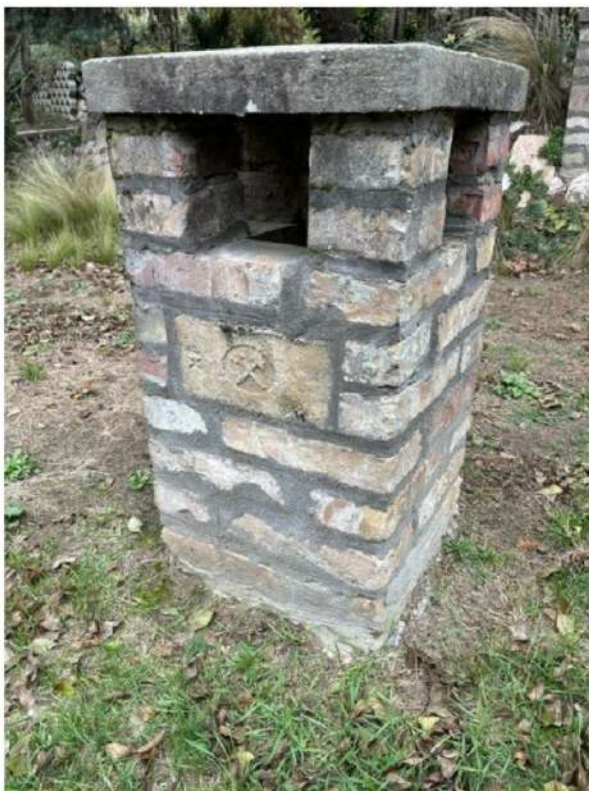
32. ábra: Varga és Fia Pincészet szellőzőkürtője (saját kép)
