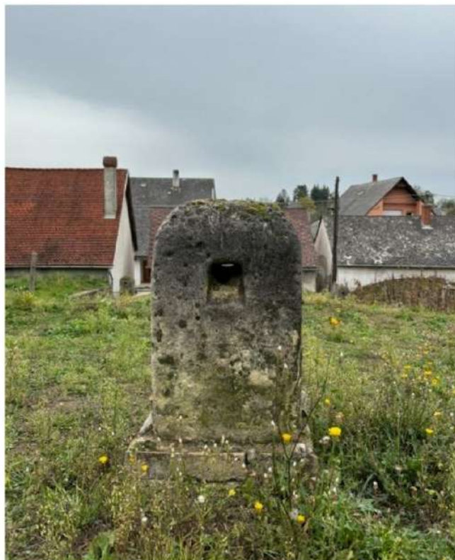
33. ábra: Petracek pince szellőzőkürtője (saját kép)
