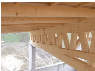
124. ábra Rácsos födém szerkezet
