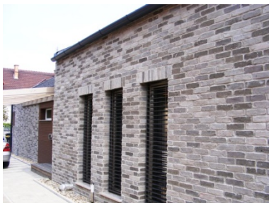
94. ábra Tégla homlokzatburkolat
