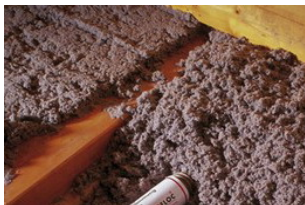
149. ábra Cellulóz hőszigetelés
