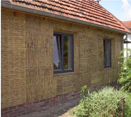
44. ábra Nádpalló homlokzati hőszigetelés
