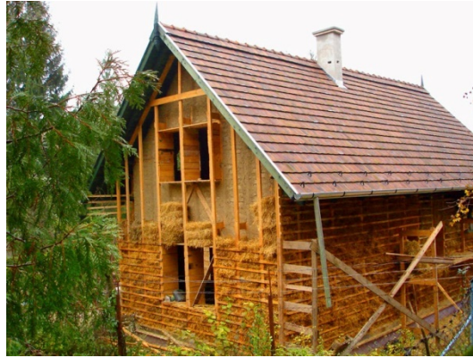
23. ábra Favásas szalmabála homlokzati hőszigetelés
