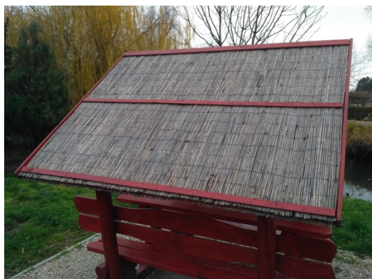
48. ábra Nádszövet borítás pavilonnál
