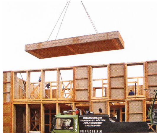
27. ábra Favázás, szalma földémpanel
