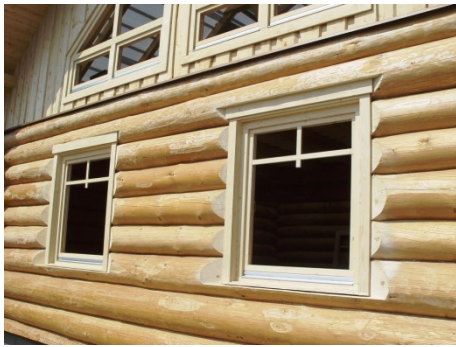
145. ábra Nyílászáró kialakítása rönkházban
