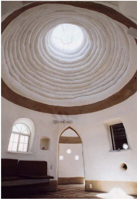
59. ábra Szupervályog ház kupola
