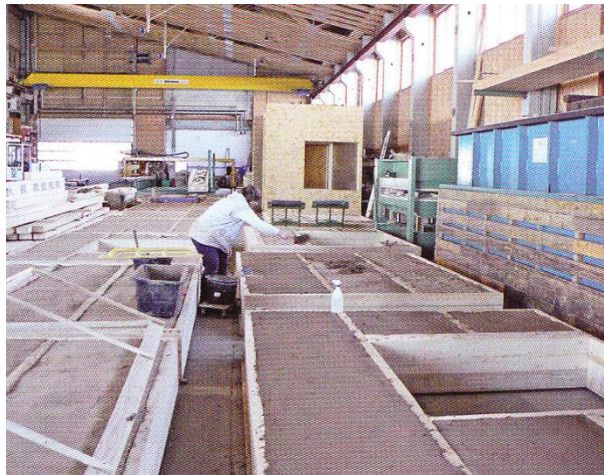
21. ábra Szalma falpanel vályogtapasztása
