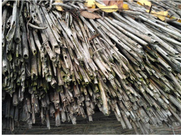
35. ábra A nádtető elhasználódása
