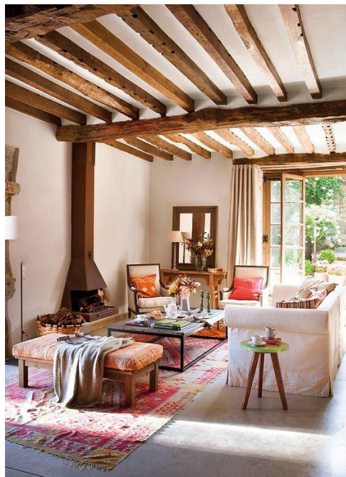
78. és 79. kép – épület renoválás és mestergerendás födém
