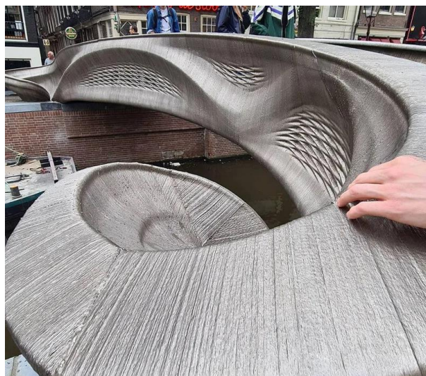
18. ábra 3D nyomtatott fém híd Amszterdamban
