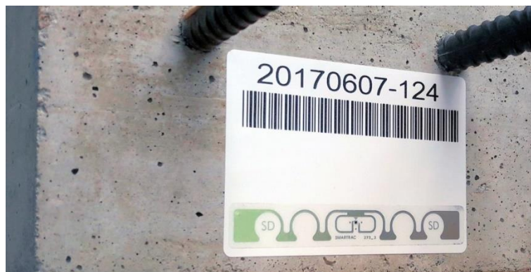
106. ábra RFID címke vasbeton szerkezeti elemen
