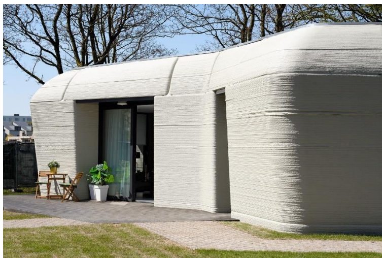
15. ábra 3D nyomtatott ház Hollandiában
