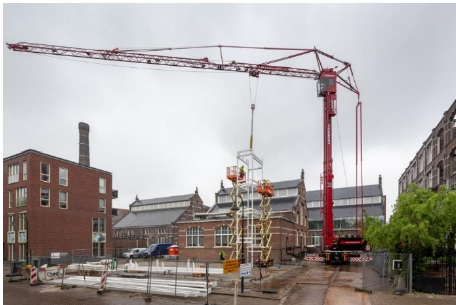
111. ábra Demountable Office Building Acél szerkezeti elemek daruzása
