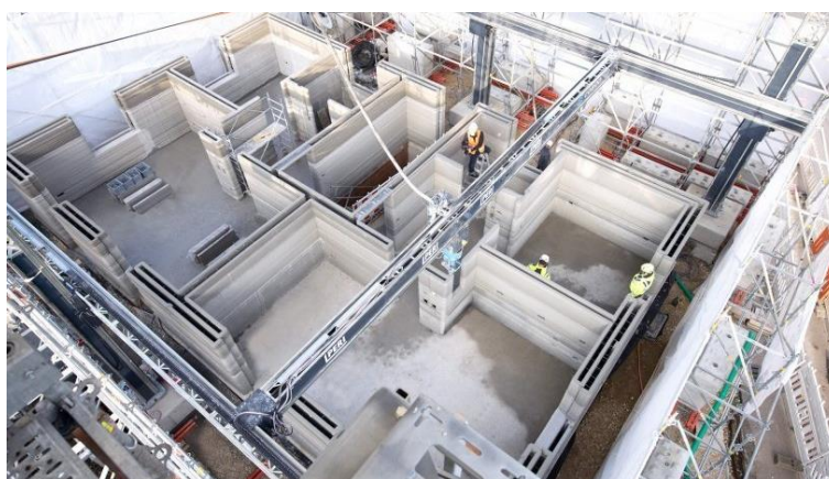
16. ábra 3D háznyomtatás folyamat közben
